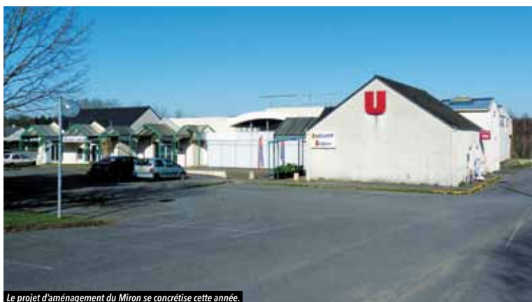
Le projet d'aménagement du Miron se concrétise cette année.
