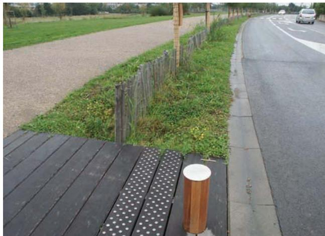
**Les aménagements travaillent sur la perméabilité des surfaces : stabilisé et vaste bande enherbée permettent à l'eau de s'infiltrer partiellement dans le sol.**
