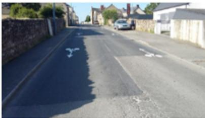
**Rue François Rortais** : Une **CVCB** (Chaussée à Voie Centrale Banalisée) est réalisée entre la place St Pierre et le plateau surélevé à hauteur du chemin des Abattoirs. La CVCB a vocation à « favoriser et protéger » la circulation des deux roues, usagers les plus vulnérables.
